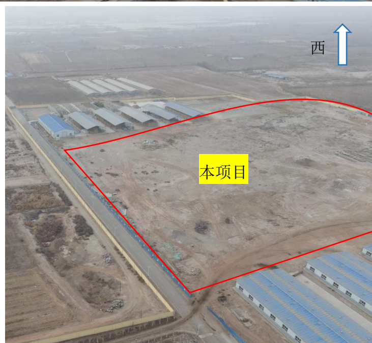
项目场址全貌
