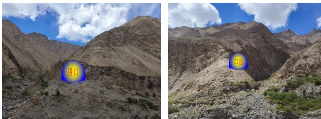
西岸隧道洞门
